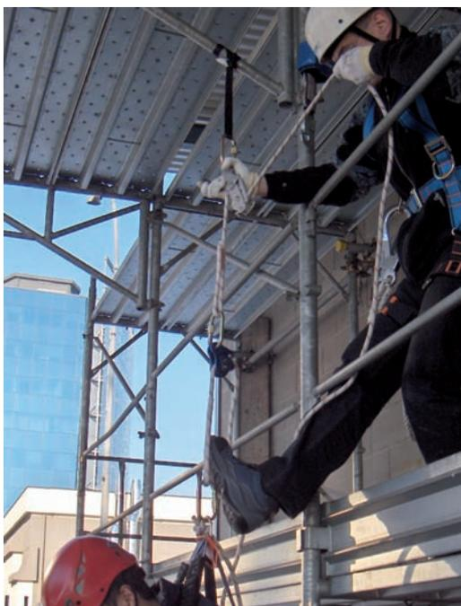
**FASE9:** Agire sulla leva del discensore antipanico tenendo tesa la corda scarica e far scendere l'infortunato. Il dispositivo antipanico mantiene bloccata la corda sia se non si effettua pressione sulla maniglia sia se la pressione è troppo elevata.
