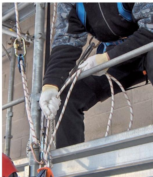
**FASE3:** Calare l'estremità munita di asola e connettore M10 del cordino 5m connesso allo Stopfor K, avendo cura di lasciare almeno 40-50 cm di cordino uscente dallo Stopfor K al connettore M10 (v. figura in alto a destra). Agganciare il connettore M10 all'anello a D dell'imbracatura dell'infortunato. Recuperare la fune in eccesso in uscita dal discensore (non il cordino uscente dallo Stopfor K)
