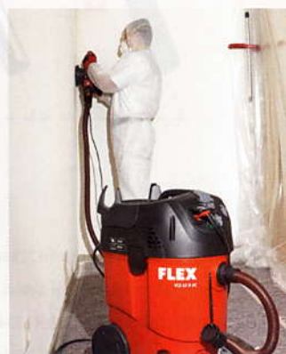
Asportazione dell'intonaco con fresatrice. I detriti e la polvere che si sviluppano si aspirano efficacemente con l'aspiratore di sicurezza FLEX VCE 45 H AC.
