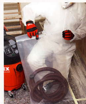
Gli accessori contaminati da polveri nocive possono essere sigillati e protetti a norma per il trasporto.
