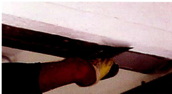
Stucco epossidico bicomponente con elevata tixotropia, privo di solventi ideale per:
