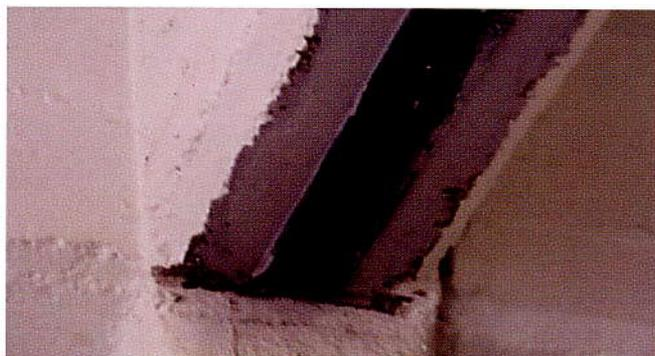
Lamine in fibra di carbonio disponibili in diversi moduli elastici e dimensioni ideali per il rinforzo e per il placcaggio. Da utilizzarsi mediante incollaggio con EC-PLASTER per:
