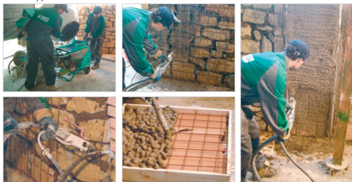
Lancia: fughe, rasanti, pittura, iniezioni, con raccordi
